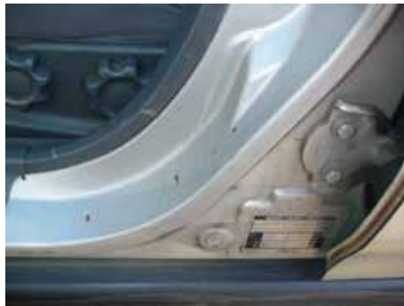
Niet acceptabel (sponning gedeukt/roestvorming)
